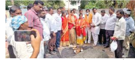
రోడ్డు పనులు ప్రారంభించిన మేయర్, కార్పొరేటం
